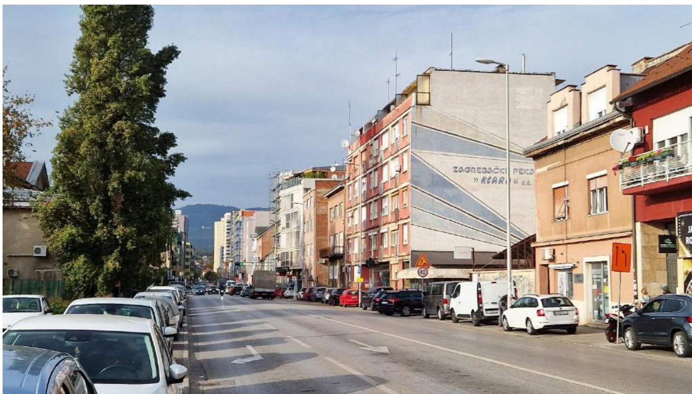
Sl. 128. Koridor Nove ceste u kojem, osim u najsjevernijem segmentu, više nema nijednog stabla; jablan u prednjem planu nalazi se u dvorištu osnovne škole
